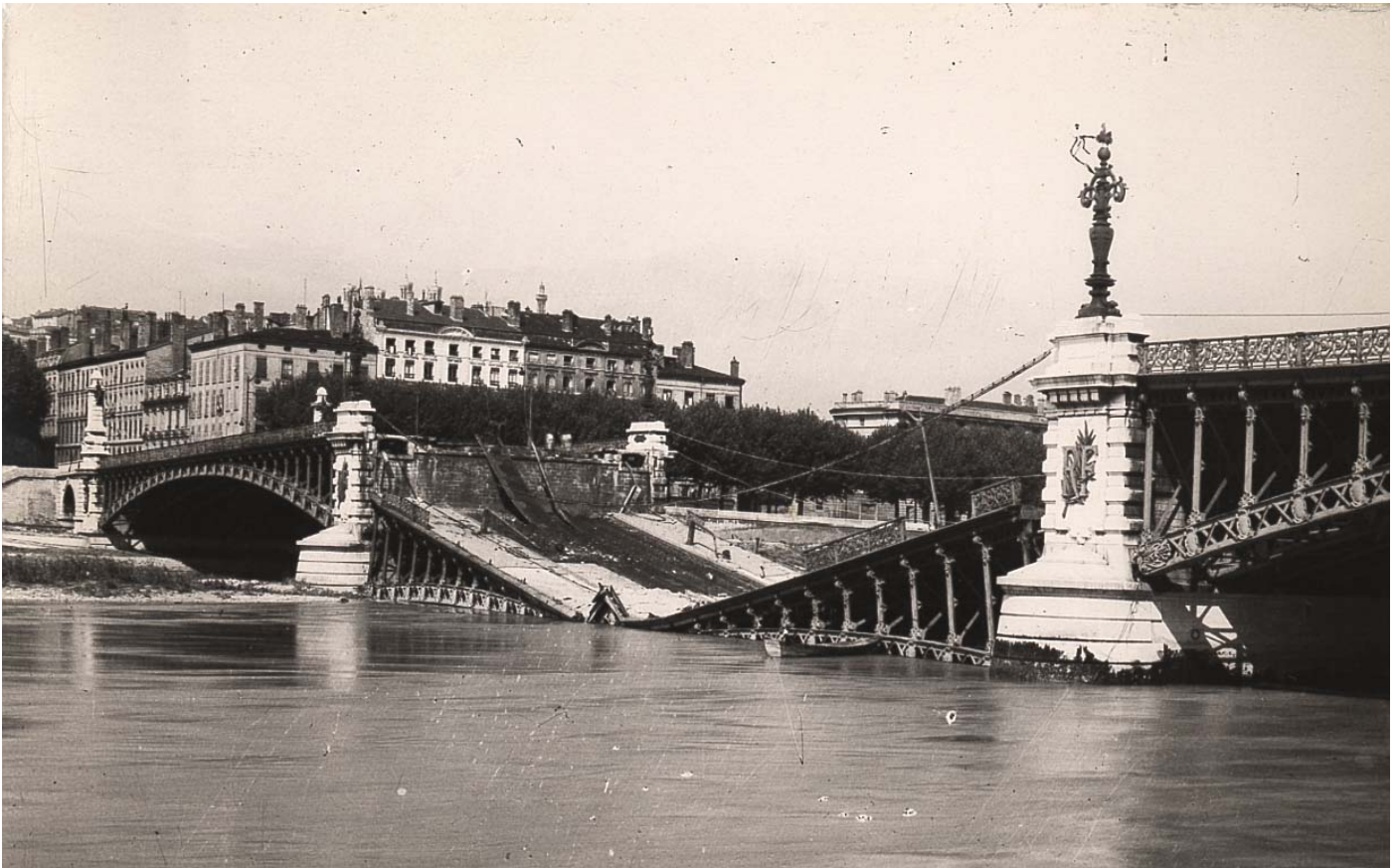
Le pont de l'université après le bombardement du 26 mai 1944. © Collection X- Droits réservés
